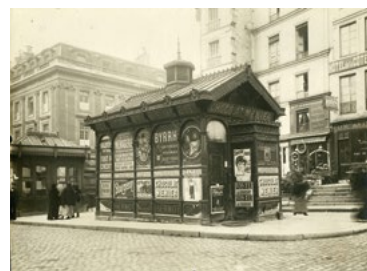
Chalet de nécessité rue de Rivoli, mars 1908, V37M1_1(36) © Archives de Paris
