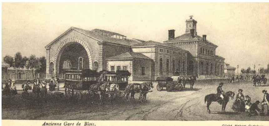
Ancienne Gare de Blois.
