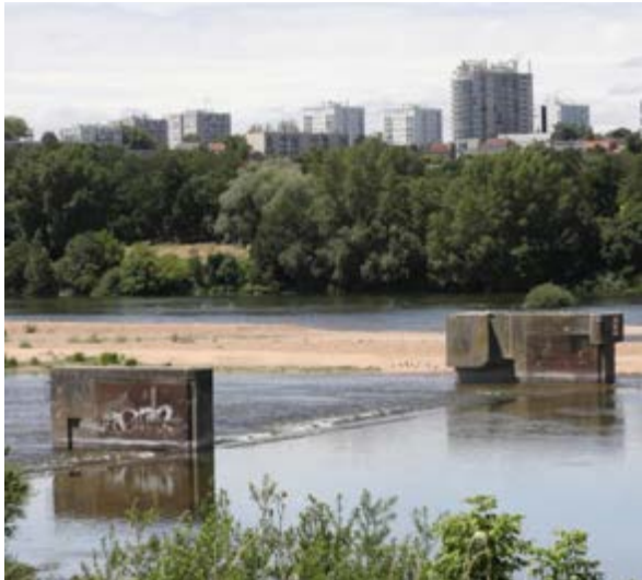
Les traces de l'ancien barrage de Loire qui abritait avant 2005 une zone de loisirs nautiques. (Photo NR, Jérôme Dutac)
