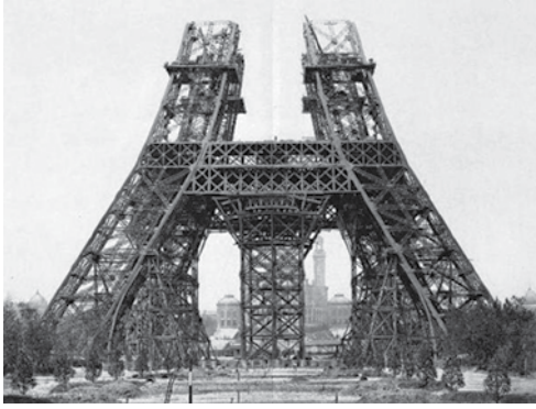
La tour Eiffel en construction (1888) © Droits réservés
